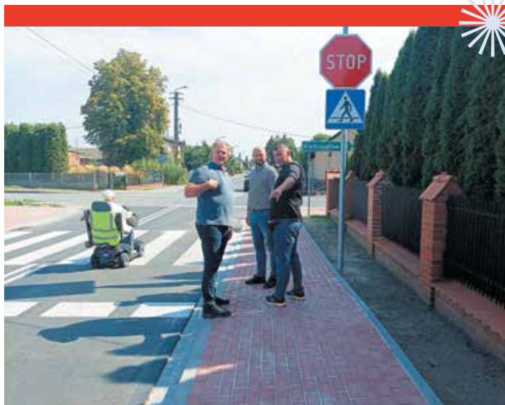
Odbiór drogi w Prądzewie
