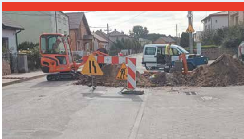
Budowa kanalizacji na ulicy Mickiewicza
